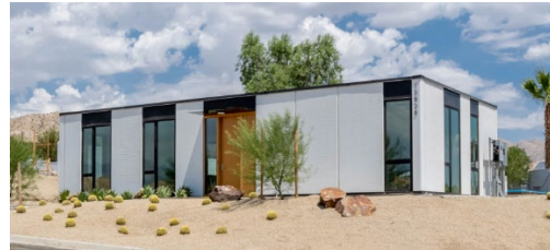
Figura 33 Unidad impresa en 3D en la comunidad de Desert Hot Springs por Mighty Buildings.
