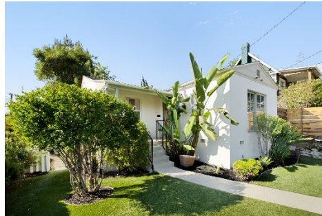
Figura38. Casa de 1937 en Highland Park, Los Ángeles, convertida en dúplex.
