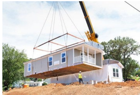
Figura 30. Casa prefabricada siendo izada con grúa desde la plataforma del camión hasta los cimientos.
