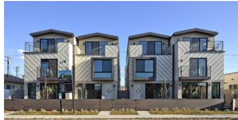
Figura 31. Cuatro viviendas adosadas con certificación LEED Gold (8000 pies cuadrados) ensambladas a partir de 6 módulos de Plant Prefab en Venice, California.
